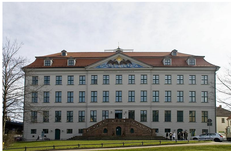
Figura 6 – Edifício original do orfanato da Fundação Francke 28
