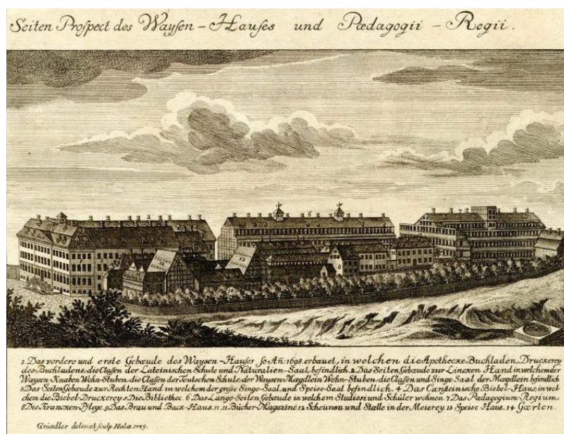
Figura 4 – Visão geral da Fundação Francke, Alemanha 26
