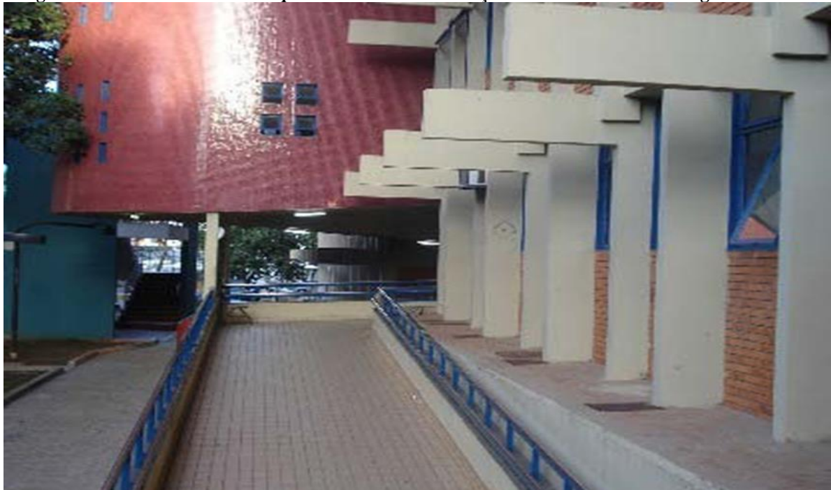
Imagem 2 - Prédio do bloco 4k no qual funcionam as instalações da ESTES/UFU – Inaugurado em 1996.
